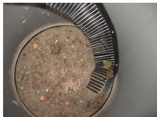
Foto's 26 en 27. Het zogenoemde vogelschroot laat zich diverse standen bevestigen en leent zich met name voor ronde kolken. Foto 26 foto geeft de meest geschikte bevestigingswijze aan.
