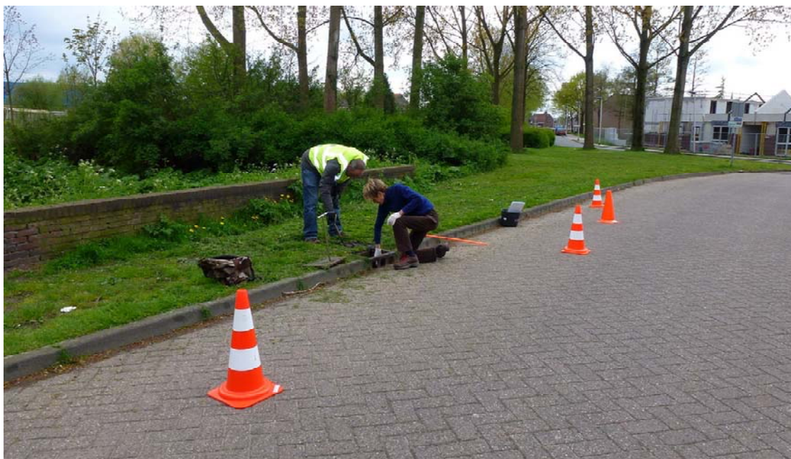
Foto 44: inspectie van een van de 15 trottoirkolken in Helmond
