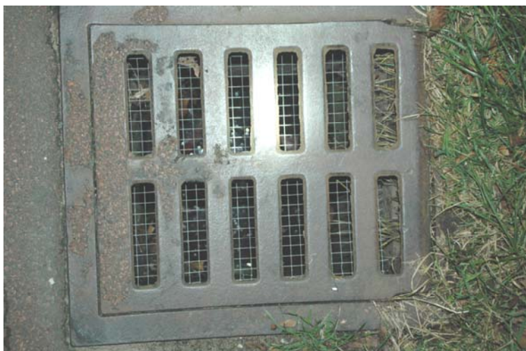
Foto 21: Horizontale gazen strip onder een straatkolk. Waterdoorlaatbaar nylon doek kan ook op deze manier gebruikt worden.
