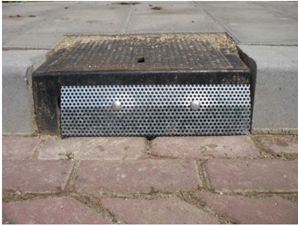
Foto 15: De zogenoemde Padstelling is een reeds in de handel zijnde voorzetrooster voor trottoirkolken.
