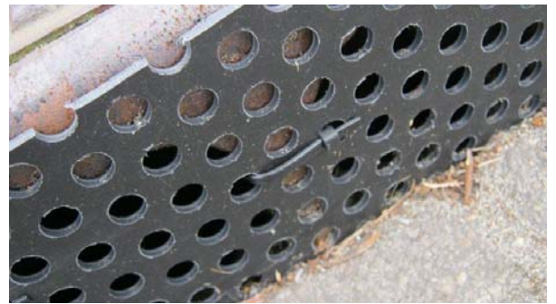
Foto's 16 en 17: Metalen voorzetroosters (Den Haag). In Den Haag worden momenteel kunststof strips als voorzetrooster gebruikt.
