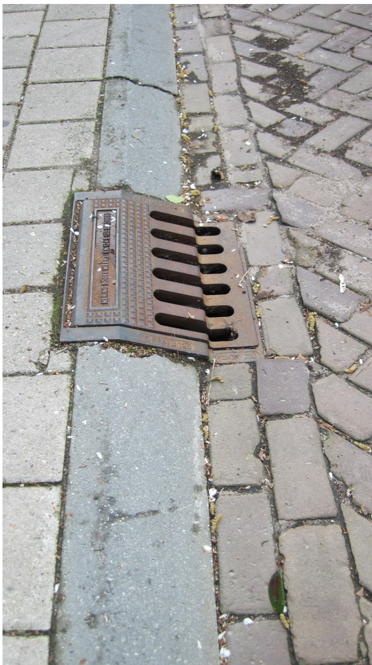
Foto 12: Ook in trottoirkolken met een schuine rand komen amfibieën terecht. Dat bleek uit de aangetroffen dieren in zulke kolken op de locatie Beek-Ubbergen tijdens het onderzoek van 2012. Door nader onderzoek kan informatie verkregen worden of over grotere lengtes verlaagde trottoirbanden het aantal kolkenlachtoffers substantieel verminderen.
