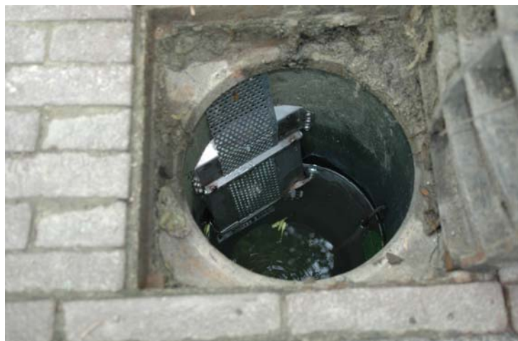
Foto 36: Combinatie van een putklep en een uitklimstrip voor amfibieën. Als pilot heeft Waternet, de waterbeherende instantie voor de regio Amsterdam, deze voorziening in 400 kolken in het Vondelpark ingebouwd.
