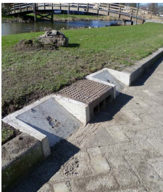
Foto 13: Schuine stoeptegels als 'paddenoprit' in Pijnacker-Nootdorp. In een eerste experiment met 25 kolken leverde dit vooralsnog geen substantiële vermindering van het aantal kolkenslachtoffers op. Mogelijk levert verlaging over grotere afstanden of een ander model tegel betere resultaten op; verder onderzoek hiernaar is gewenst.
