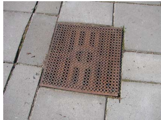
Foto's 19 en 20: Horizontaal rooster, op of onder het deksel van een straatkolk te plaatsen (Amstelveen).
