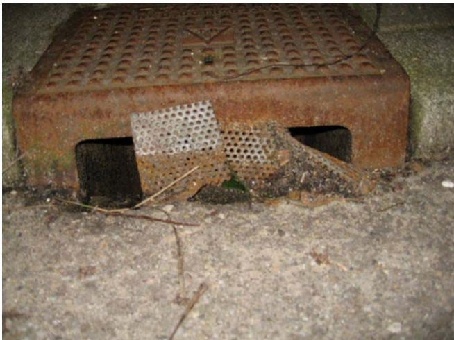
Foto 18: Voorzetrooster, beschadigd door een veegmachine. Delft, 2012. Foto KNNV afdeling Delfland.
