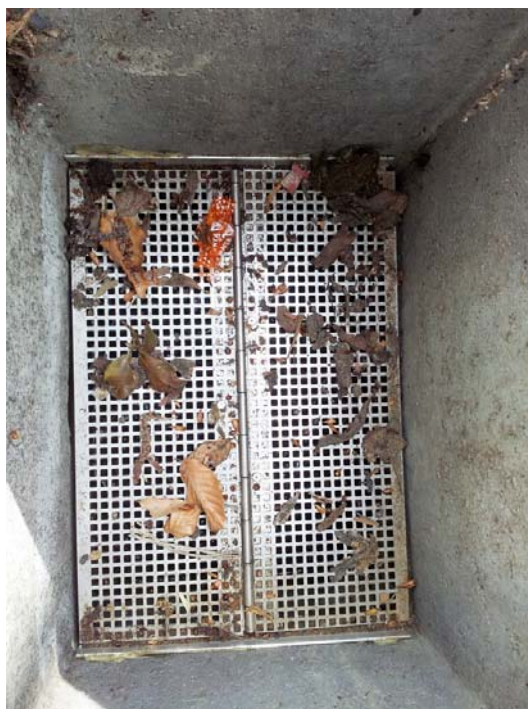
Foto 22: Bovenaanzicht opvangzeef rechthoekig model Biodiversitysafe. Buiten het vangseizoen kan de constructie in opgeklapte situatie in de kolk blijven.
