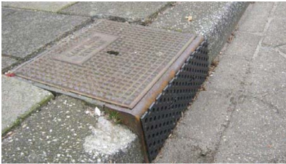
Foto's 16 en 17: Metalen voorzetroosters (Den Haag). In Den Haag worden momenteel kunststof strips als voorzetrooster gebruikt.
