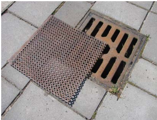
Foto's 19 en 20: Horizontaal rooster, op of onder het deksel van een straatkolk te plaatsen (Amstelveen).
